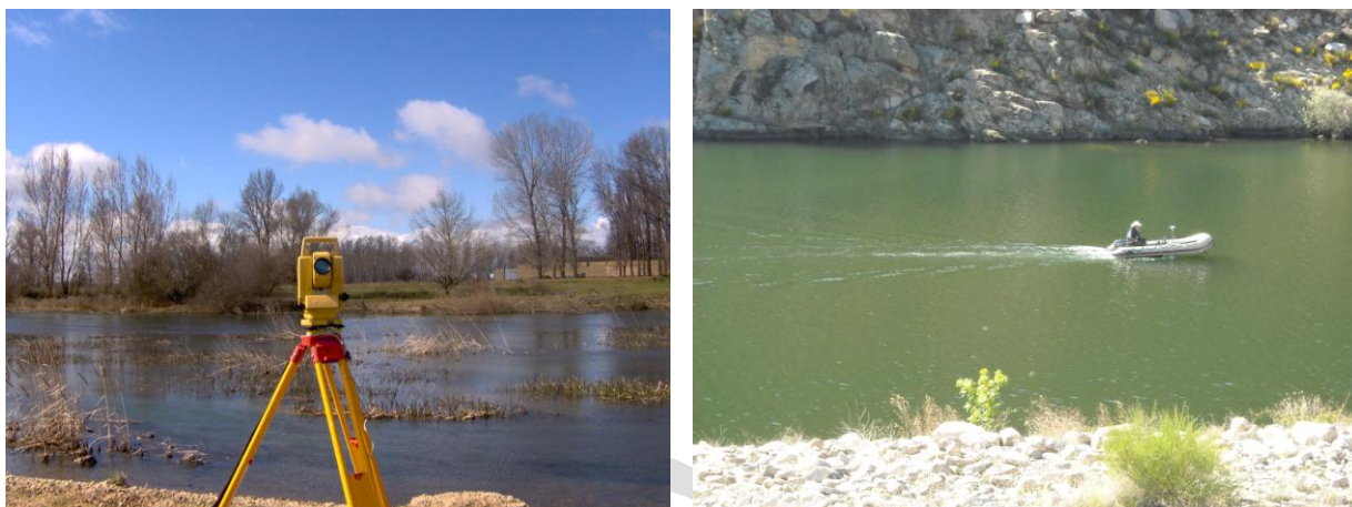
Toma de datos cauce mediante estación total y ecosonda acoplada a embarcación
