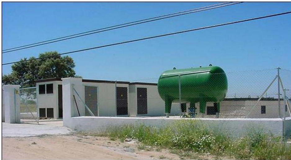
Figura 6. El desarrollo de las obras es bastante variable, estando más avanzada la perforación de sondeos (15 realizados y 5 en ejecución) y el tendido de la arteria aductora troncal (realizado entre Villanueva de la Cañada y Navalcarnero). Se han equipado 6 pozos, estando en ejecución otros tantos. Igualmente se han comenzado las obras de la ETAP de Griñón. (Fotografía del pozo GU-3 en Villanueva del Pardillo)
