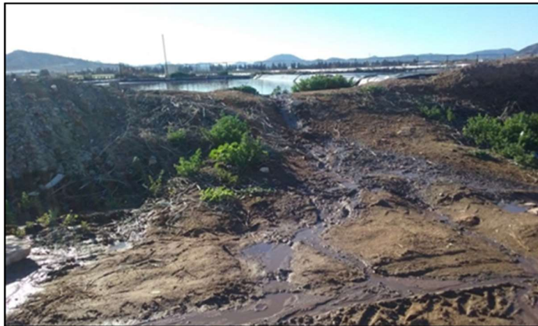
Figura 37: Desbordamiento del purín en balsa plastificada
