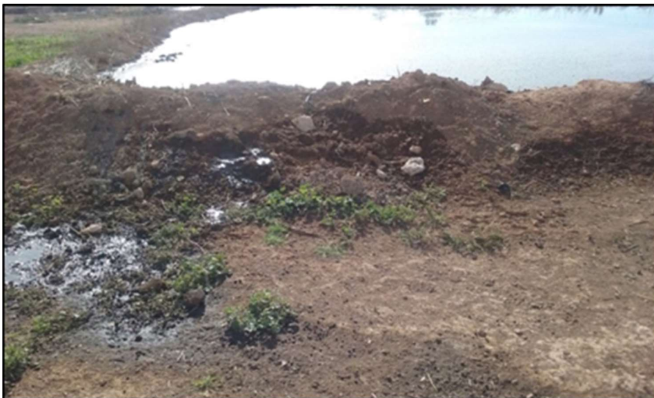
Figura 36: Desbordamiento del purín por un lateral de la balsa. Impermeabilización natural
